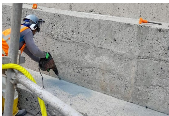
Figura 15. Execução de furos para ancoragem.
