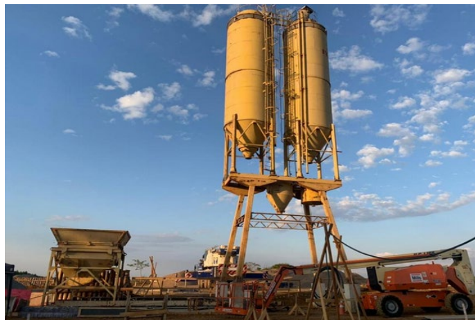
Figura 40. Central de concretagem da construtora gmaia
