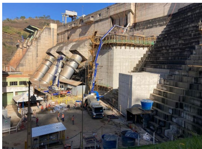
Figura 38. Bloco com forma trepante
