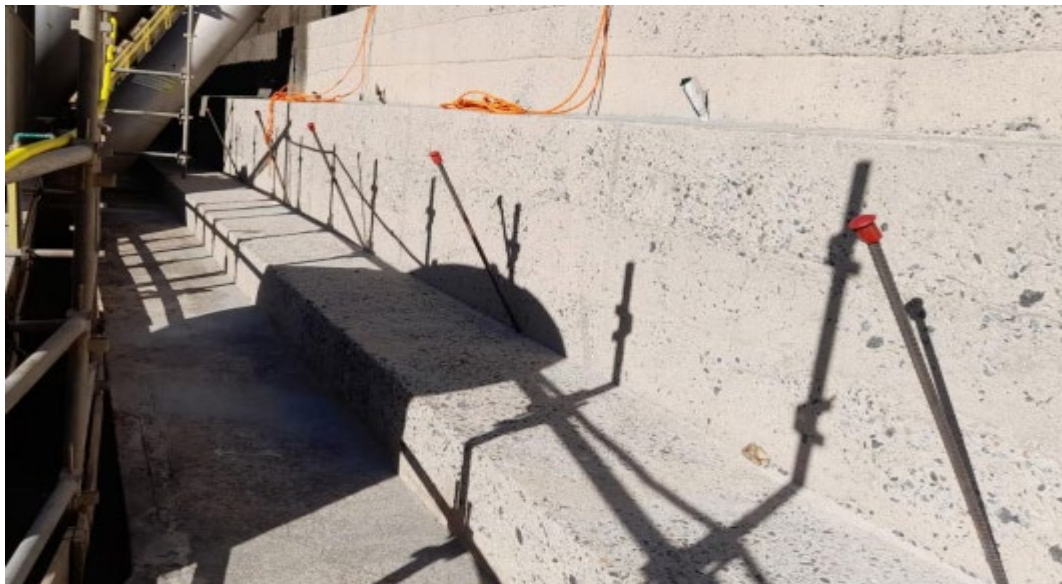
Figura 16. Ancoragem das barras de ligação.
