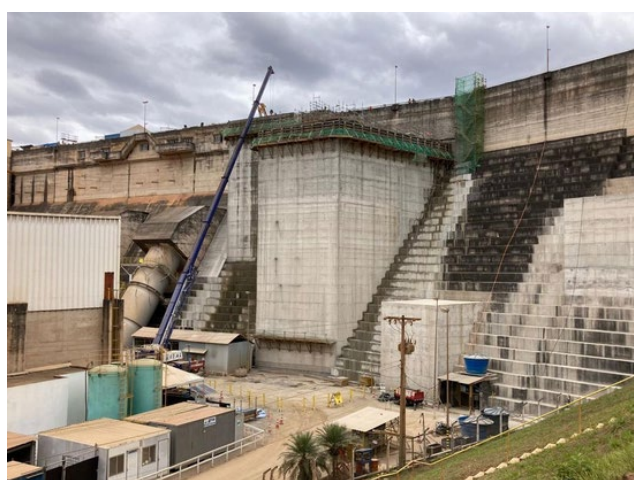
Figura 20. Sistema de formas trepantes. Fonte: acervo digital da Gmaia
