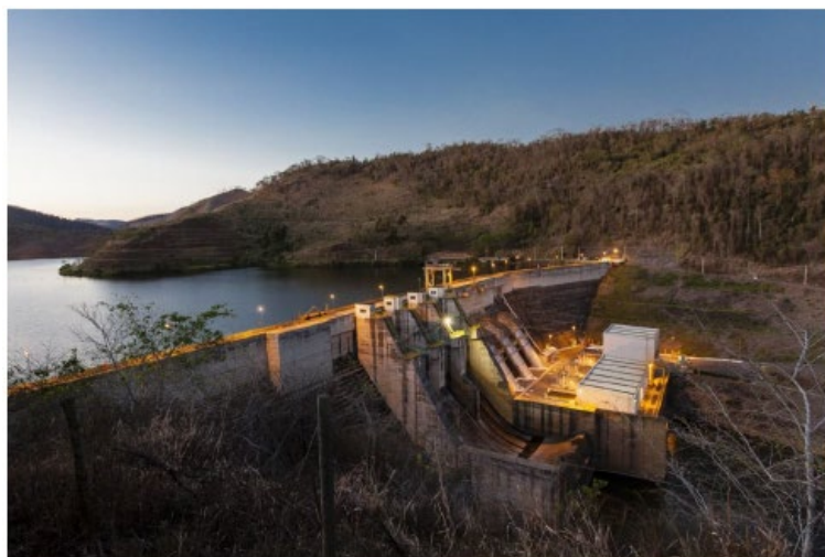
Figura 10. UHE antes do rompimento da barragem a montante.
