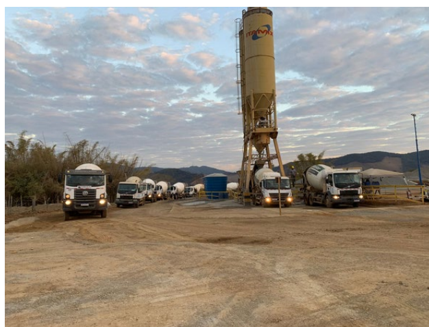
Figura 39. Central de concretagem da construtora gmaia
