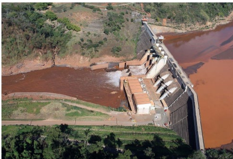
Figura 11. UHE após rompimento da barragem a montante.
