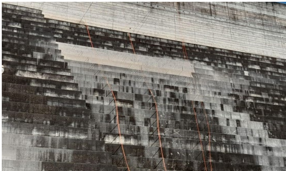
Figura 18. Hidrojateamento do BME-04.
