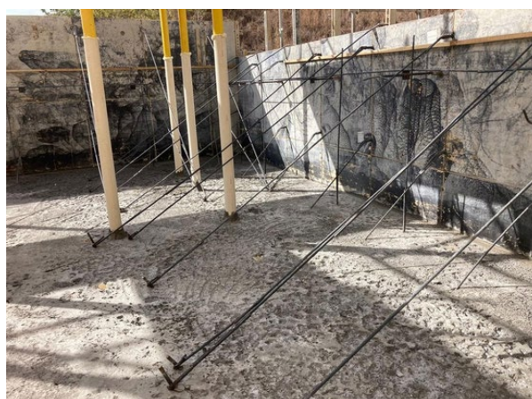
Figura 21. Sistema de tirantes internos – Forma. Fonte: acervo digital da Gmaia
