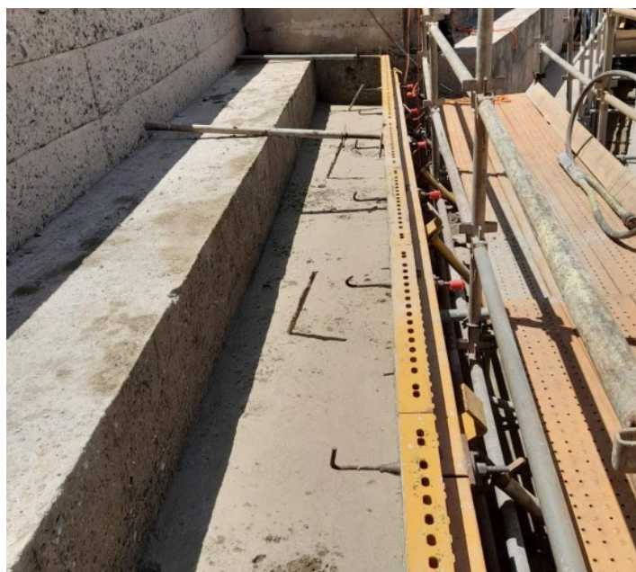
Figura 19. Concretagem da primeira camada do bloco BME-02.
